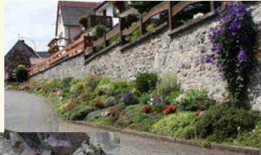
Stützmauer aus Diabas, gebrochen im Steinbruch in der Springe
